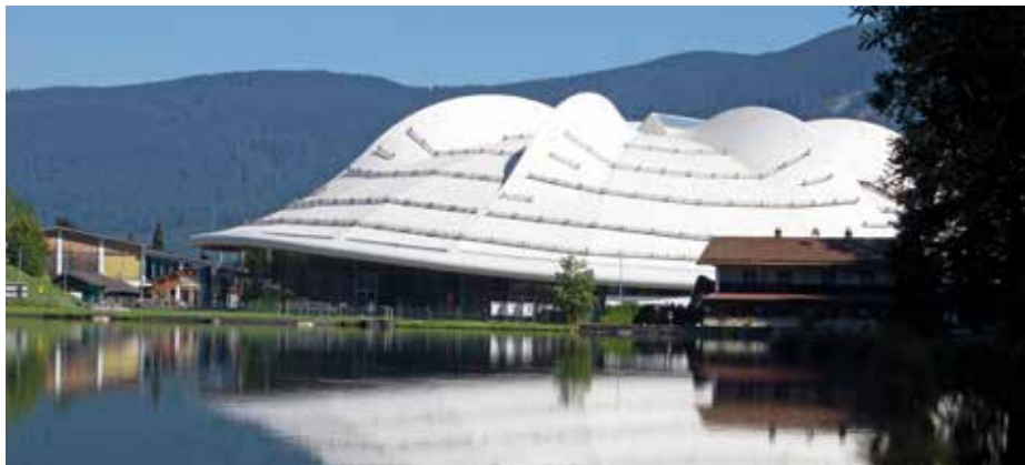
Während normalerweise Seilsicherungssysteme möglichst nahe an der Dachhaut geführt werden, musste bei der Arena das AIO-Seilsicherungssystem auf die Schneefang-Stahlkonstruktion montiert werden.
