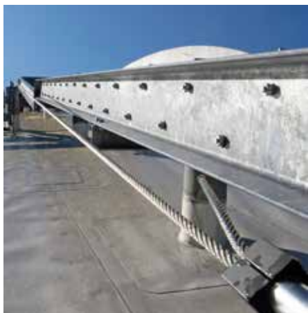
Aufgrund der bedingten Tragfähigkeit der Holz-Unterkonstruktion war es nötig, mehrere Stützen über Ecken zu führen – und trotzdem musste das System zwecks durchgehender Seilführung komplett überfahrbar bleiben.
