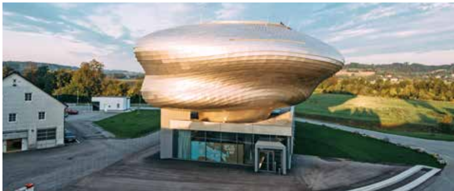
Das Paneum besteht aus zwei Gebäudeteilen: Einem ca. 17 Meter breiten, 31 Meter langen und knapp 5 Meter hohen Sockelgebäude aus Sichtbeton und einer aus 72 horizontalen Ringen frei schwebende Holzkonstruktion.
